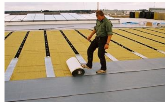
Esimerkki: Tarraava kiinnitys kattokalvolle
